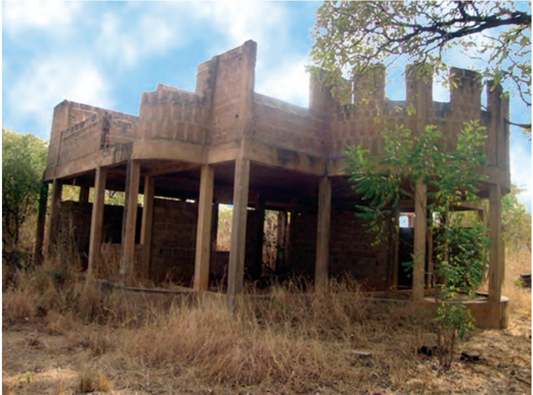
Photo du chantier abandonné depuis 2000.
