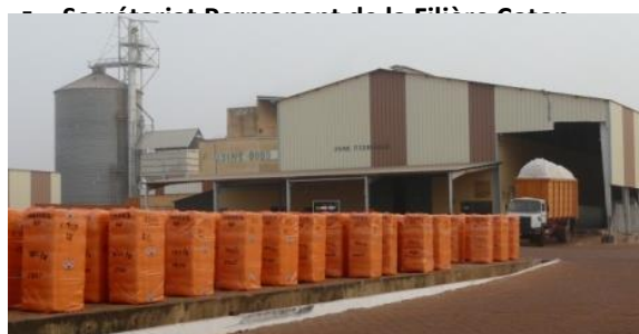
Usine d'égrenage de la SOFITEX
